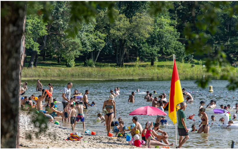
Confortement du barrage, reconstruction de la guinguette, aménagement du camping avec 24 hébergements en plus, accessibilité de la plage... soit 5M€ de travaux pour l'étang de Neufont.
