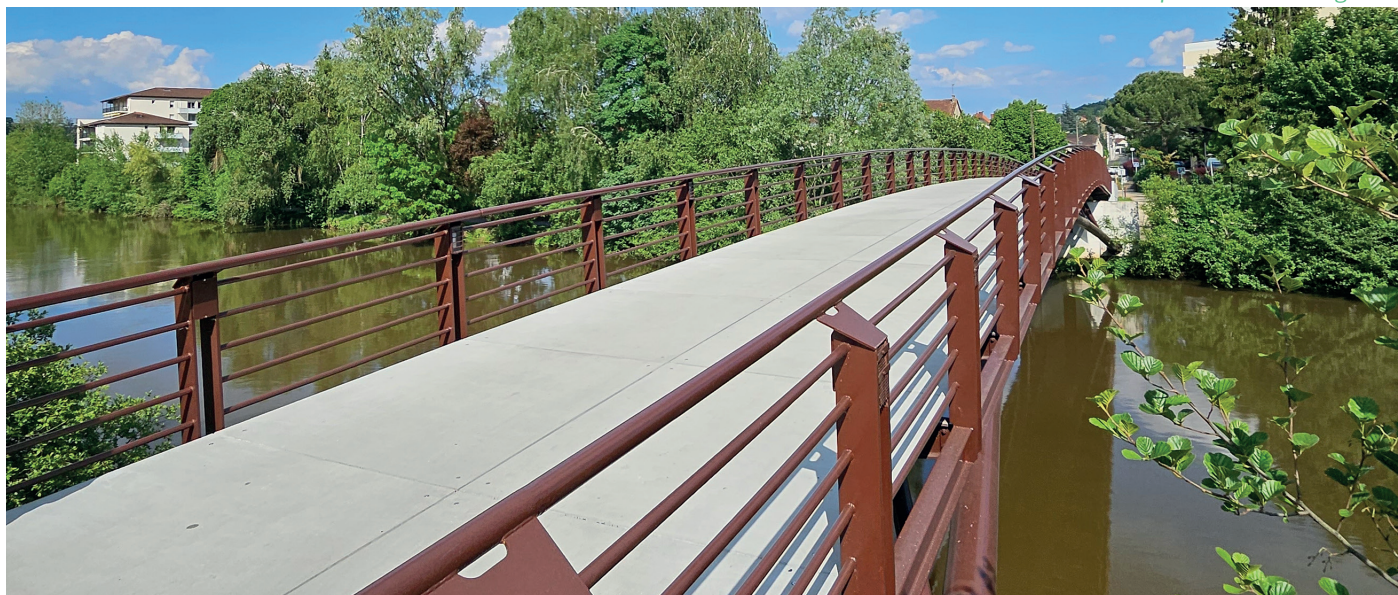
Réhabilitation de la passerelle de Périgueux.
