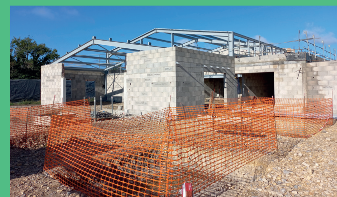
Pose de la 1 ère pierre du Sîlot, le 13 septembre 2024.
