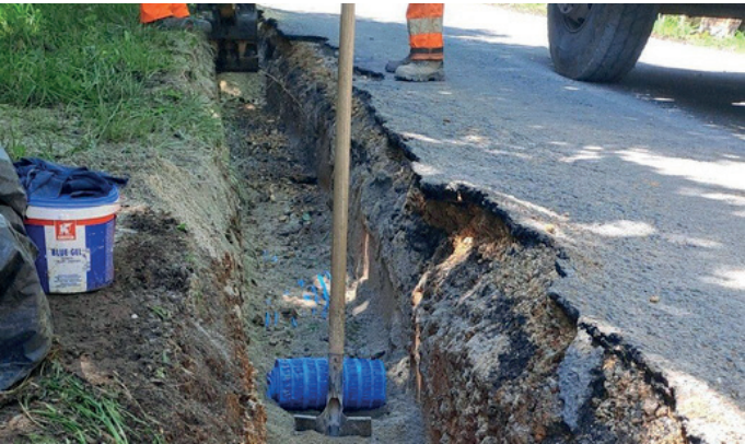
Travaux sur le réseau d'eau à Église-Neuve-de-Vergt, septembre 2024.
