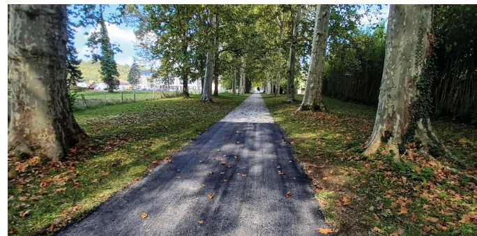
Travaux de reprise du revêtement de la voie verte à St-Laurent-sur-Manoire.
