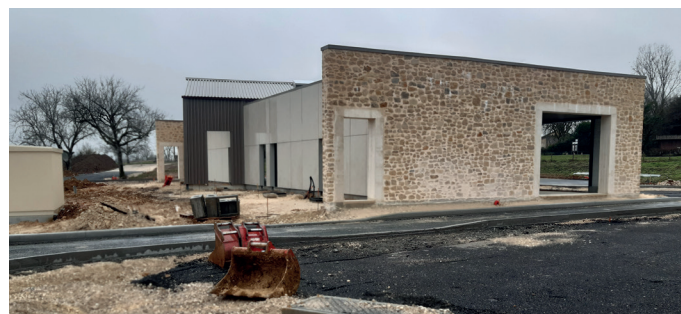
Construction sur le parc d'activité Diamant Noir à Sorges-et-Ligueux-en-Périgord.
