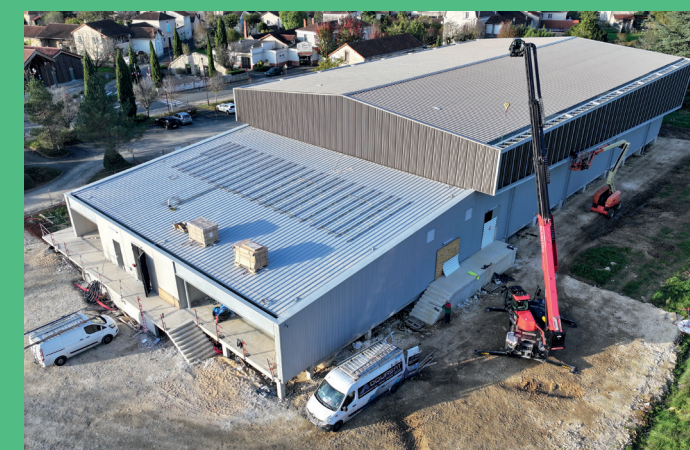
Construction d'un gymnase intercommunal à Sarliac-sur-l'Isle.
