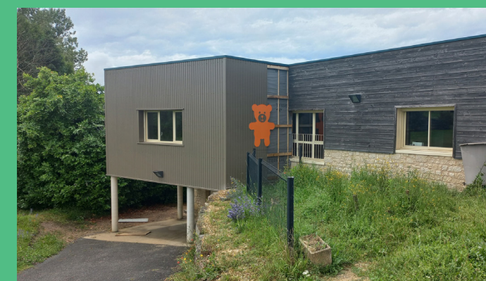
Extension de l'ALSH de Milhac avec la création d'une salle de repos, août 2024.
