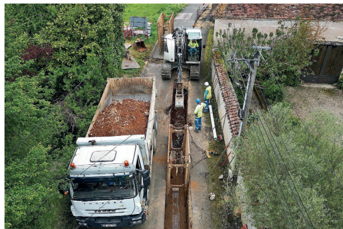
Création d'un réseau d'assainissement collectif au Change à Bassillac-et-Auberoche, juillet 2024.
