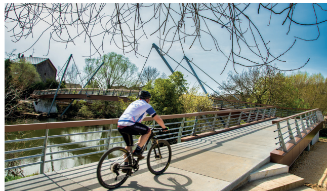
La passerelle de Barnabé qui relie Périgueux à Trélissac a été réhabilitée, mars 2024.
