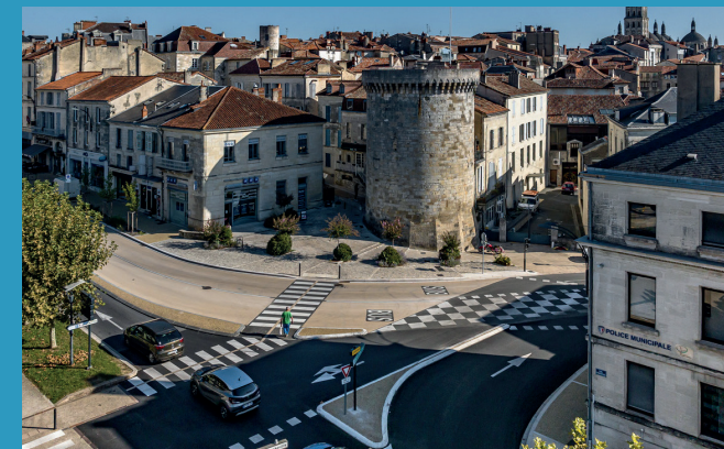
Voie de bus BHNS secteur Mataguerre à Périgueux.
