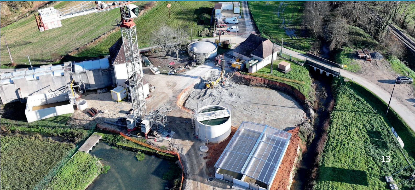
Réhabilitation de la station de traitement d'eau de Sainte-Marie-de-Chignac. Les travaux devraient s'achever en février 2026.
