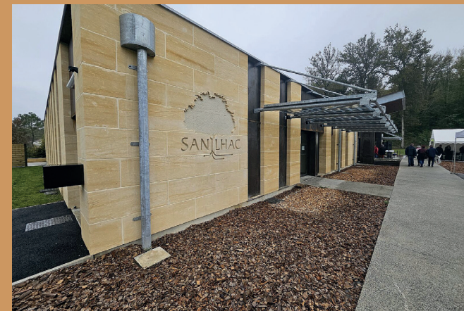
Inauguration de la Maison de Santé de Sanilhac, octobre 2024
