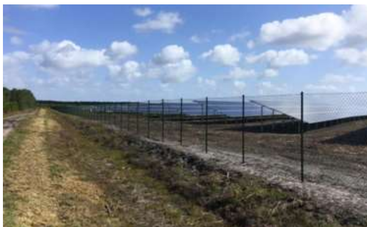
exemple de clôture (source : BayWa-r.e.)
