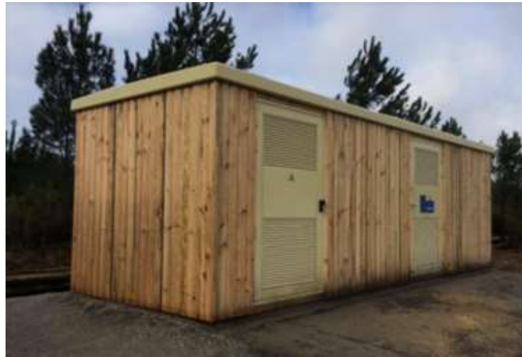
Exemple de poste de livraison bardé de bois (source : BayWa r.e.)
