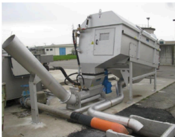
Trommel de réception des matières de vidange RoFAS HUBER associé à une presse-laveuse WAP®
