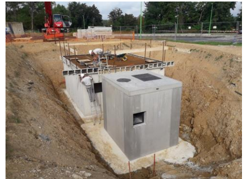
Bâche de stockage avec piège à charriages (cailloux, graviers) – Chantier de transfert des eaux usées « de Gaulle-Mériller » sur Coulounieix-Chamiers
