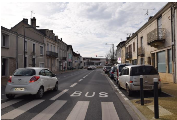
Vue ligne BHNS Boulevard de Stalingrad
