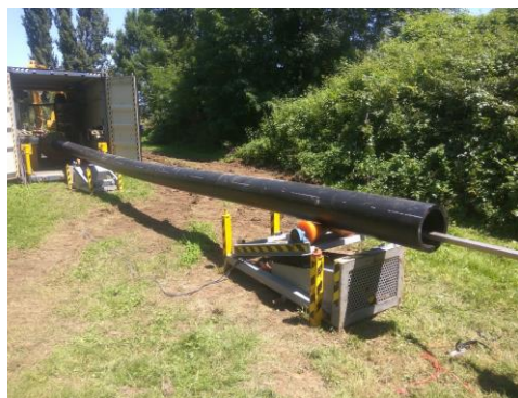
Tuyau en PEHD utilisé en forage dirigé sous la rivière l'Isle
