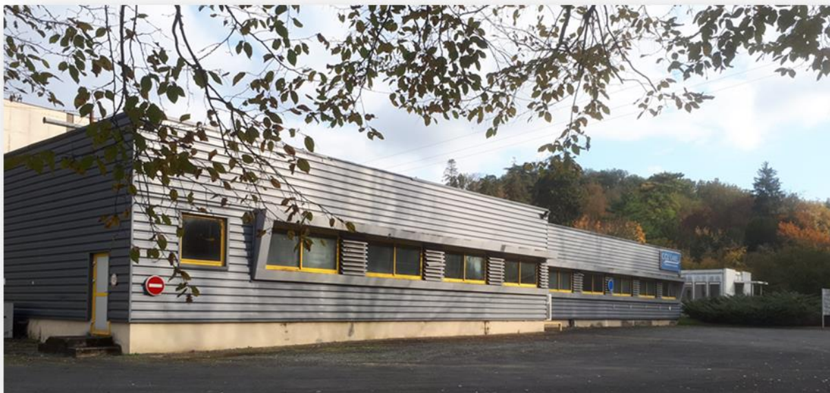
1 - Bâtiment des services techniques
