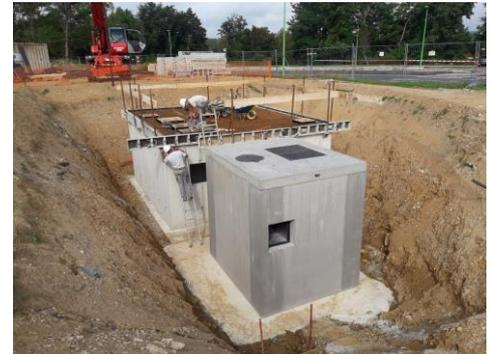
Bâche de stockage avec piège à charriages (cailloux, graviers) – Chantier de transfert des eaux usées « de Gaulle-Mériller » sur Coulounieix-Chamiers
